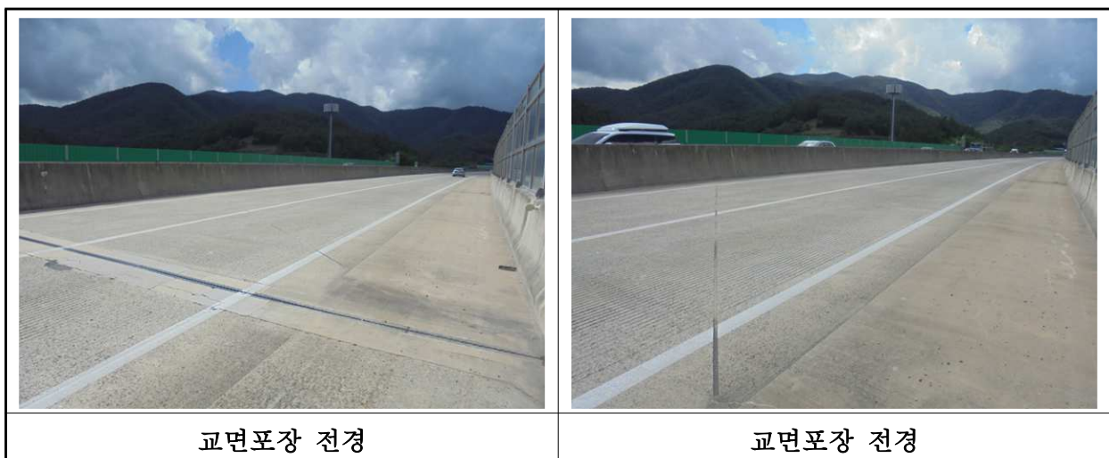
【사진 17.3.19】 교면포장 전경
