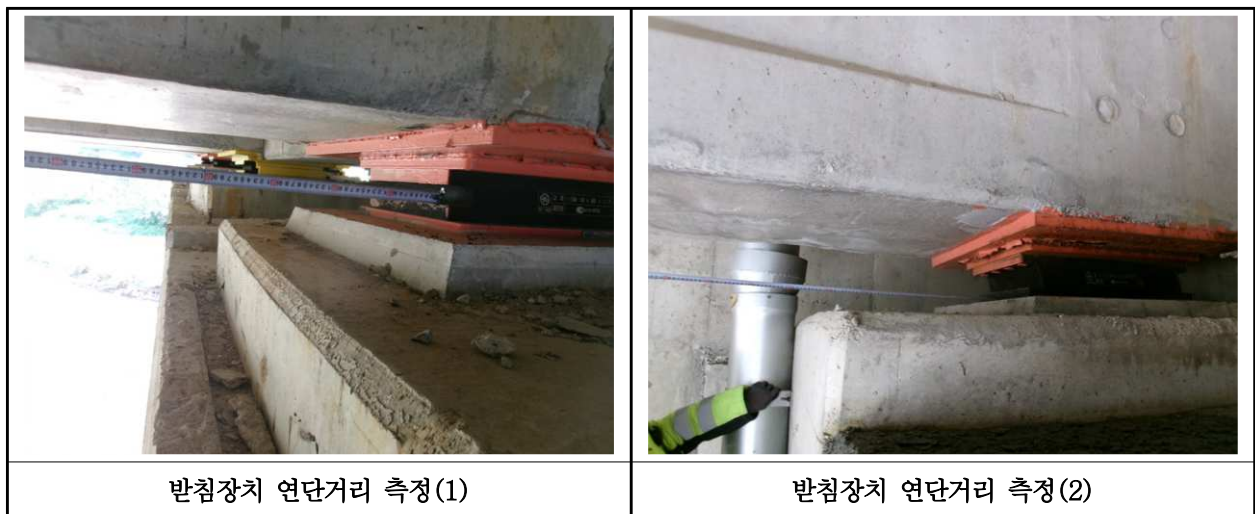
【사진 17.3.39】 교량받침장치 연단거리측정
