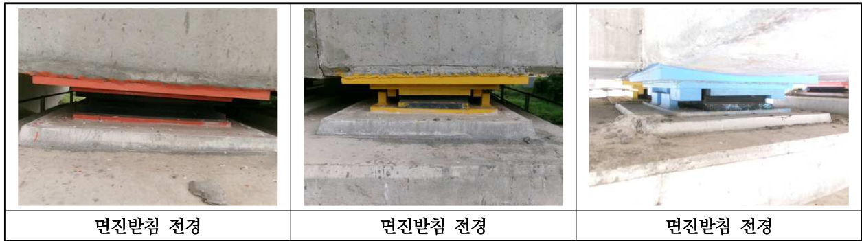
【사진 17.3.12】 교량받침 전경
