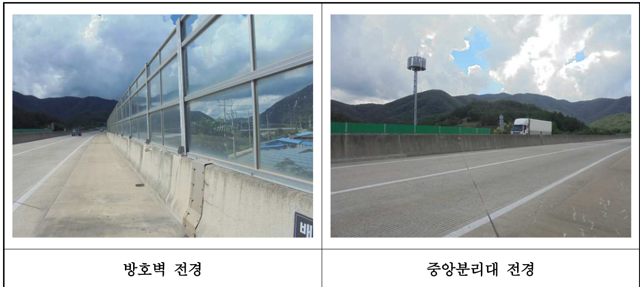
【사진 17.3.23】 방호벽 및 중앙분리대 전경
