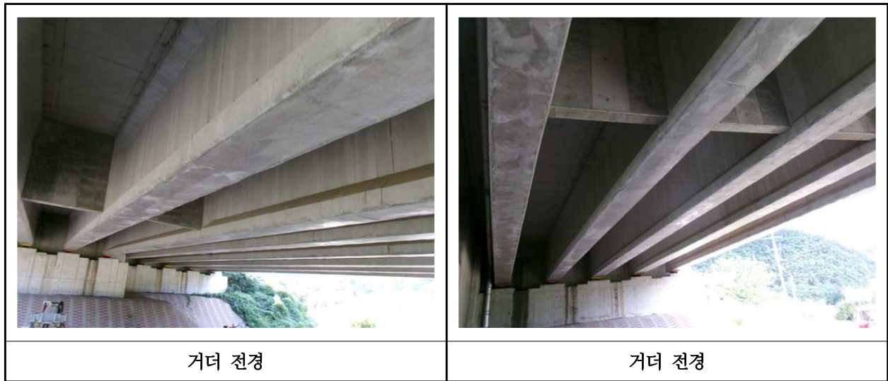
【사진 17.3.29】 거더 전경
