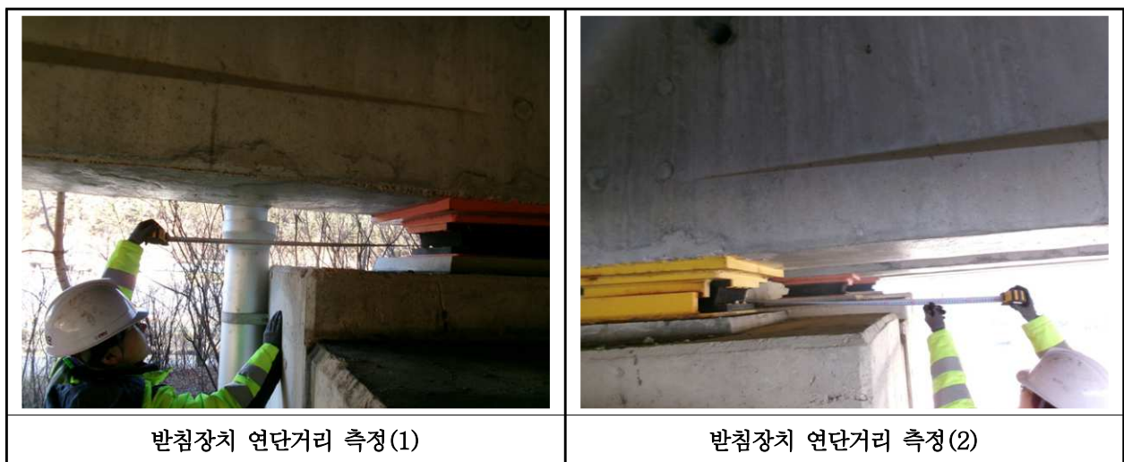
【사진 17.3.14】 교량받침장치 연단거리측정
