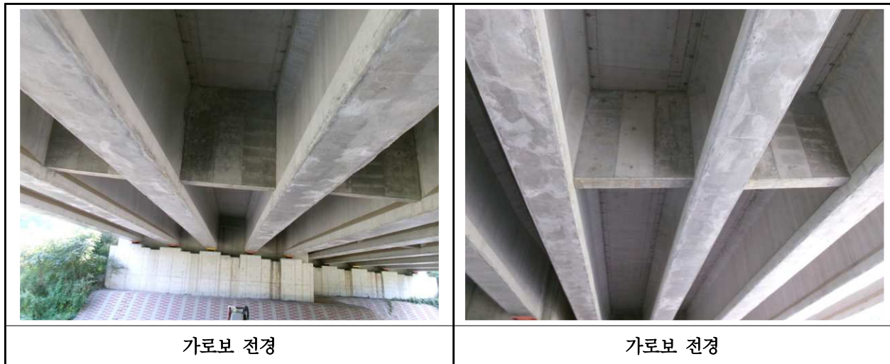
【사진 17.3.31】 가로보 전경
