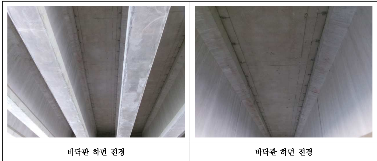
【사진 17.3.2】 바닥판하면 전경
