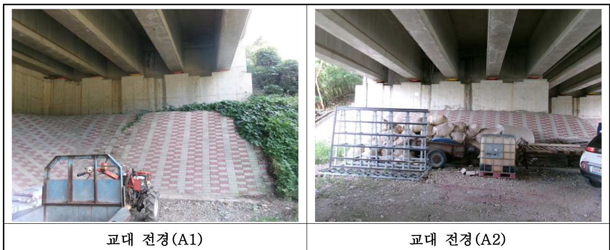
【사진 17.3.8】 교대 전경
