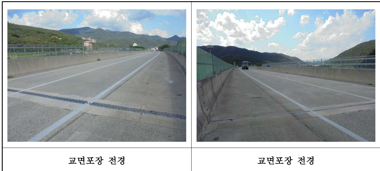
【사진 17.3.44】 교면포장 전경
