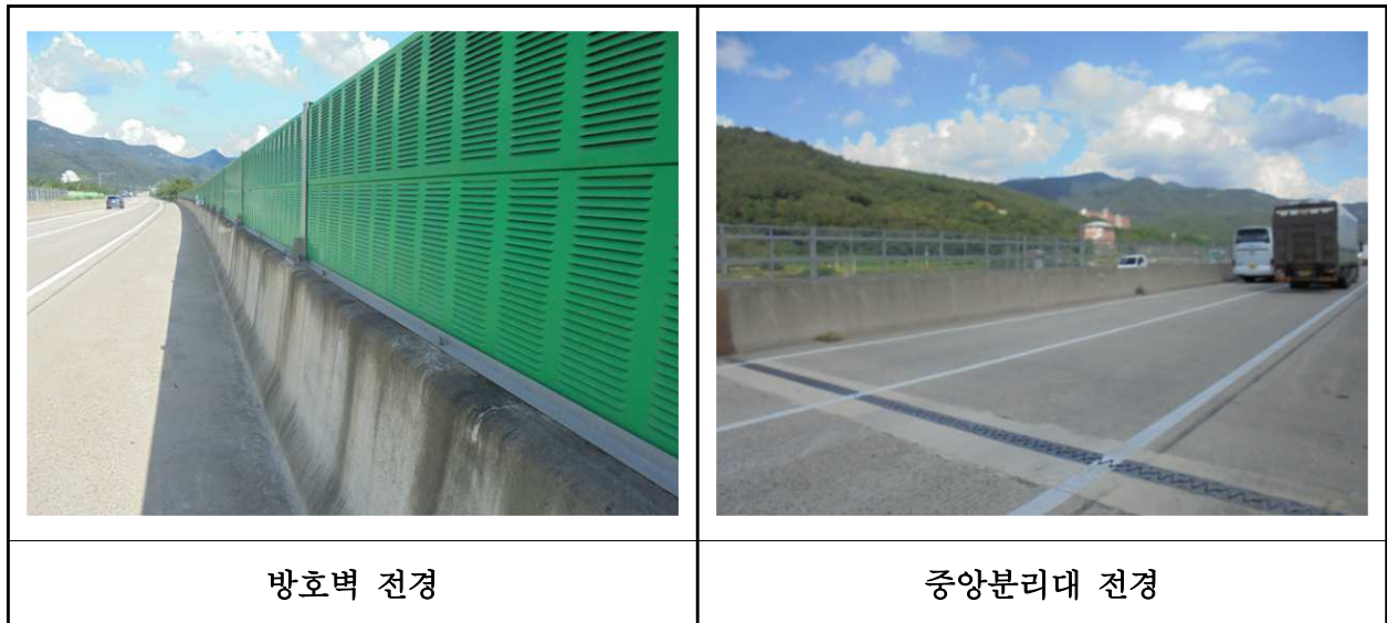
【사진 17.3.48】 방호벽 및 중앙분리대 전경
