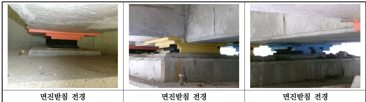
【사진 17.3.37】 교량받침 전경
