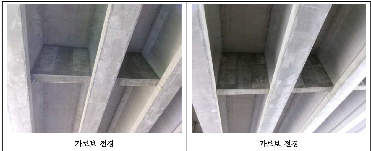
【사진 17.3.6】 가로보 전경
