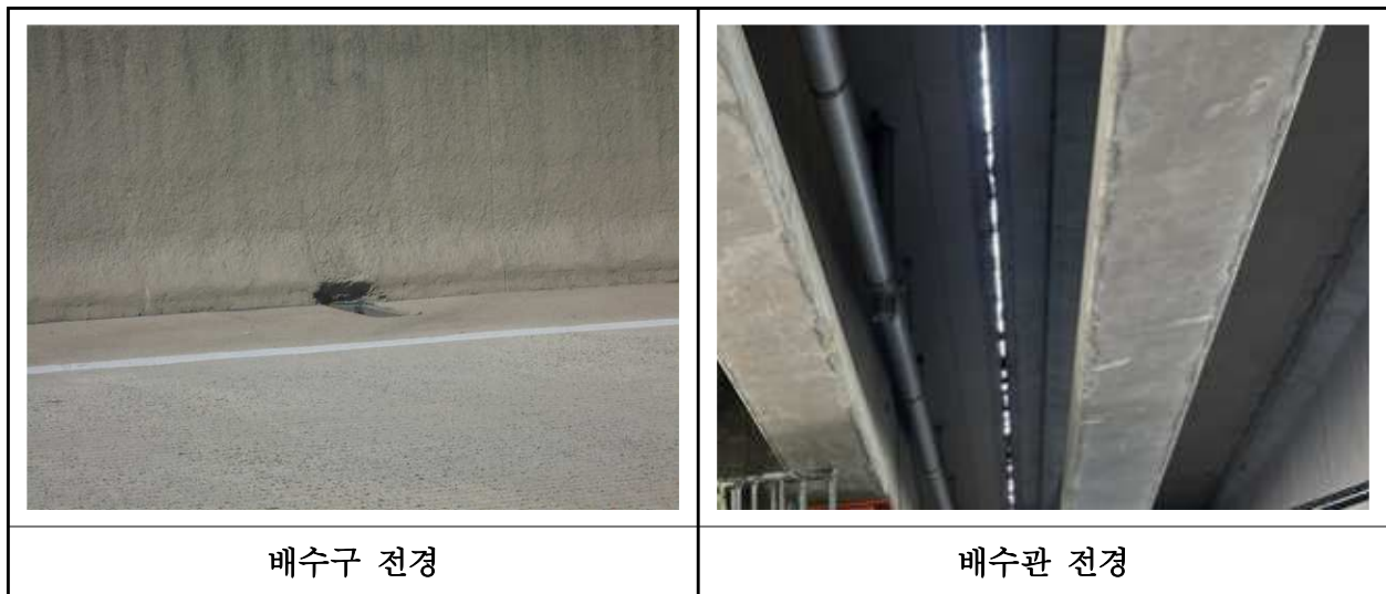
【사진 17.3.46】 배수시설 전경
