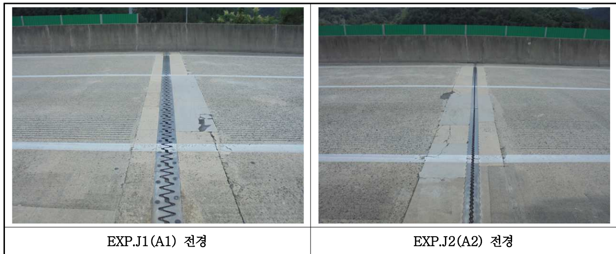
【사진 17.3.16】 신축이음장치 전경
