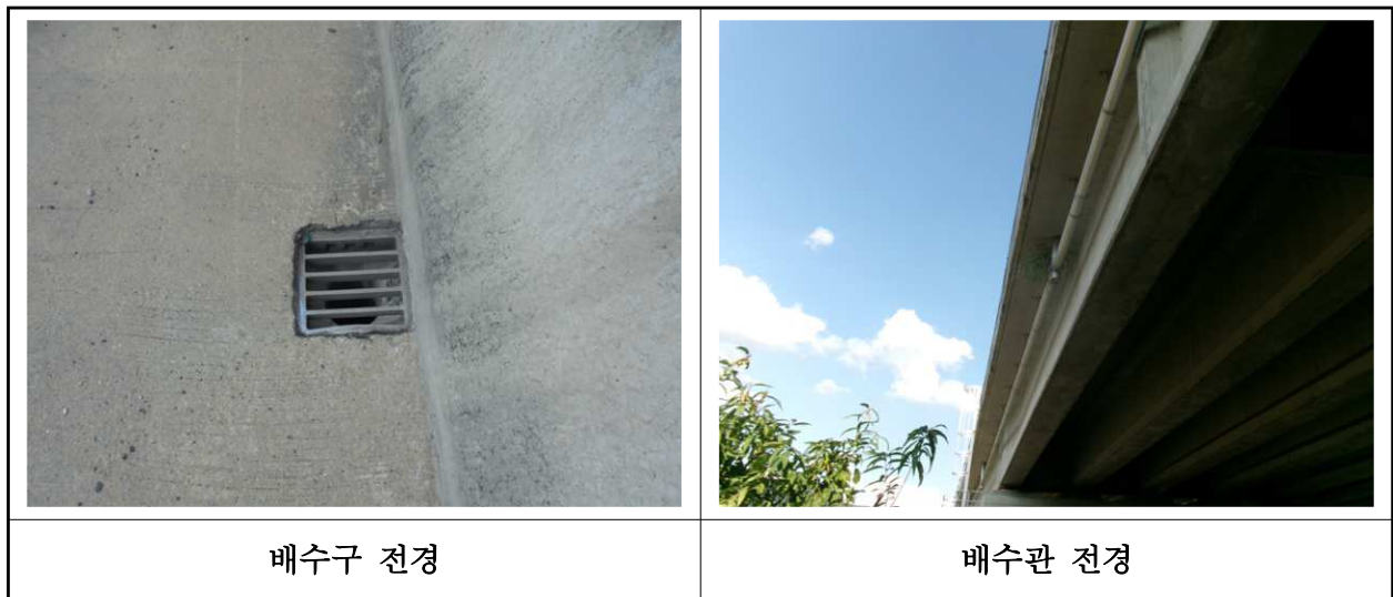
【사진 17.3.21】 배수시설 전경
