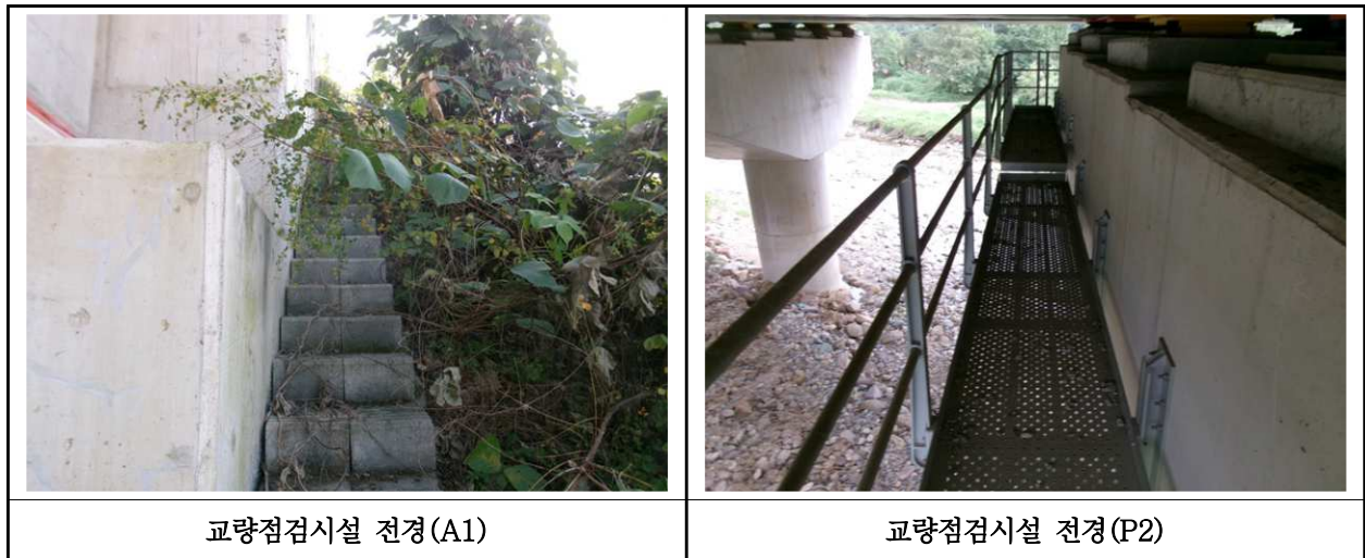
【사진 17.3.25】 교량 점검시설 전경
