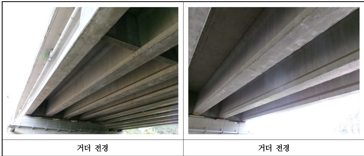
【사진 17.3.4】 거더 전경
