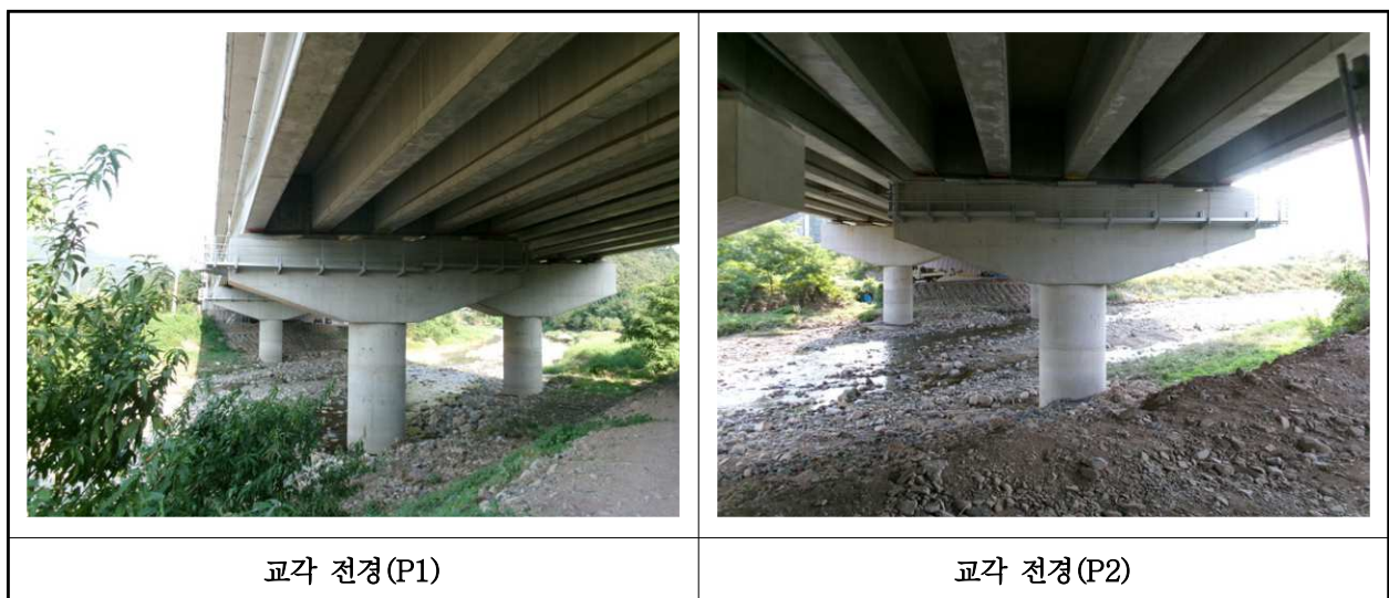
【사진 17.3.10】 교각 전경
