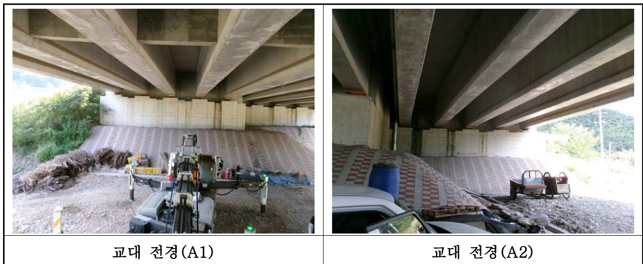
【사진 17.3.33】 교대 전경
