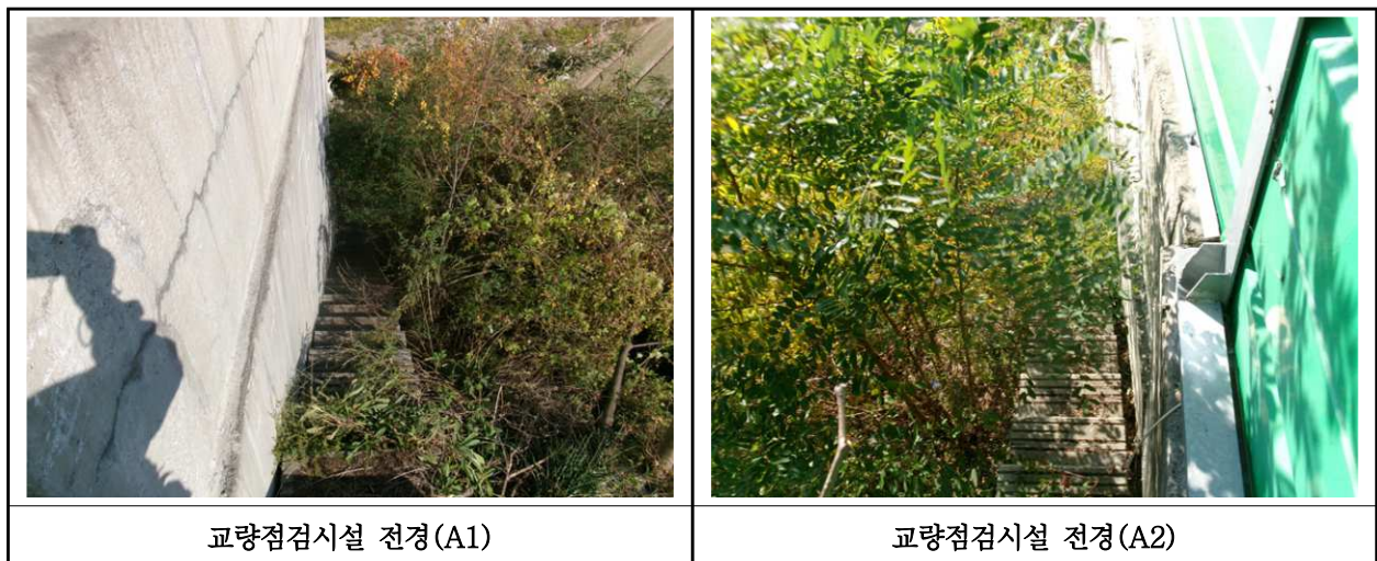
【사진 17.3.50】 교량 점검시설 전경
